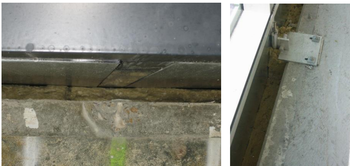
Afbeelding 28 - Brandwerende afdichting EI 60 met rotswol tussen de zijkant van de vloerplaat en het vlamdichte gevelement (linkerfoto: Brandweer Leuven; rechterfoto: SECO).
