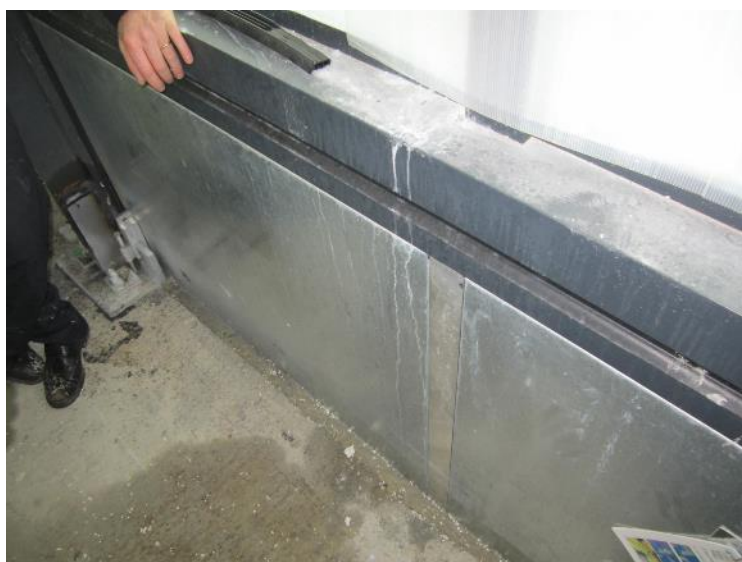
Afbeelding 27 - Vlamdicht gevelement E 60 opgebouwd uit inwendige staalplaten (Brandweer Leuven).
